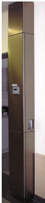
Energieversorgungs- und Steuerungsmodul auf der Patientenstation. Sonderausführung mit abschließbaren Abteilen für das Anschlusskabel und das Bedienpaneel.
