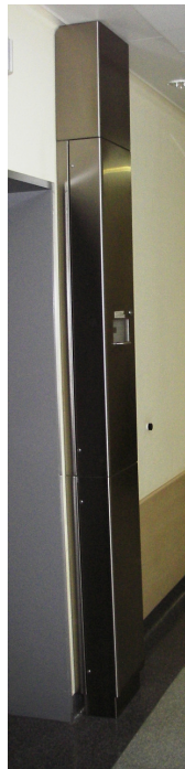
Energieversorgungs- und Steuerungsmodul auf der Patientenstation. Sonderausführung mit abschließbaren Abteilen für das Anschlusskabel und das Bedienpaneel.
